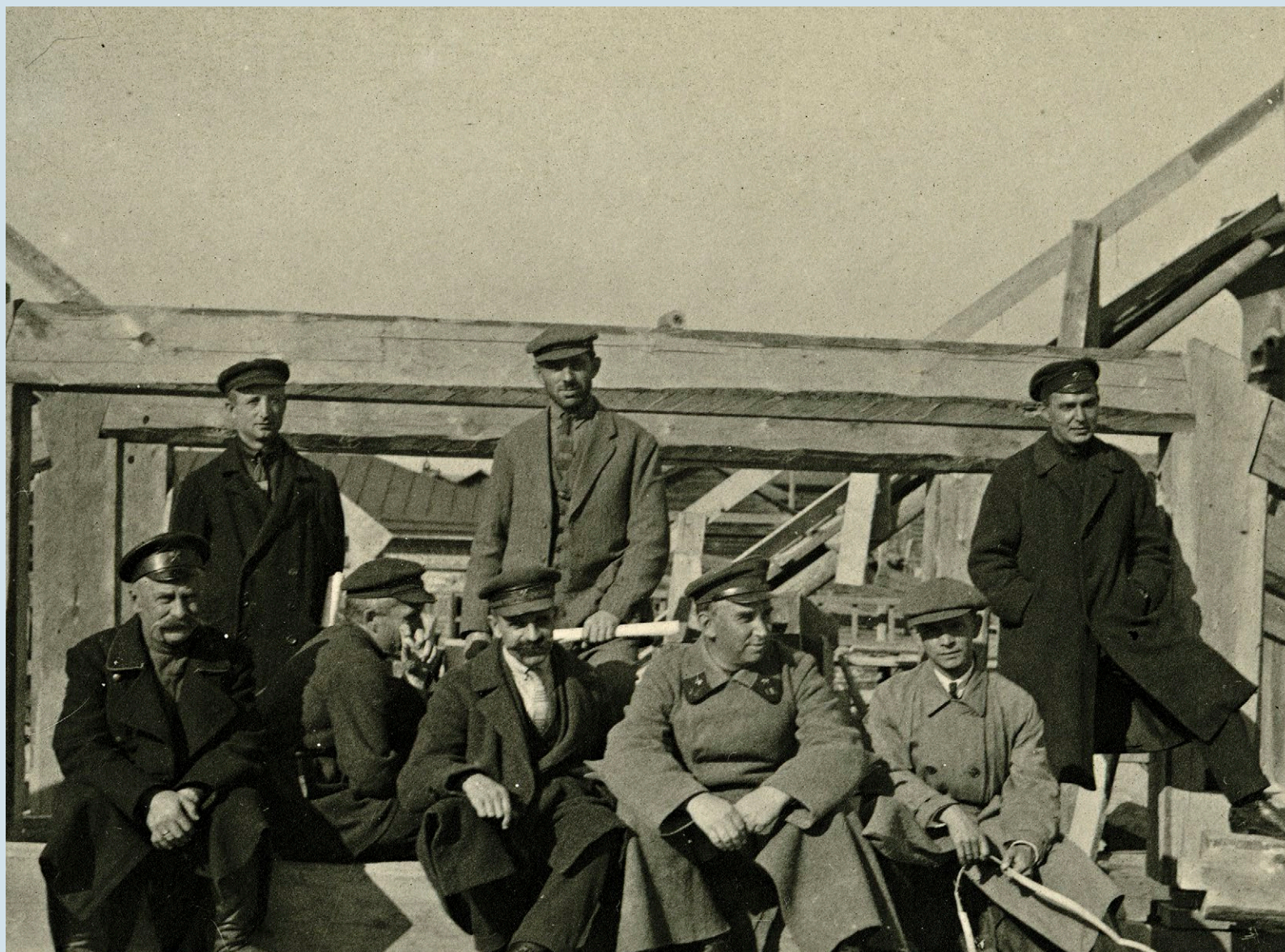
Строительная комиссия на крыше музея, 1928–1929 годы
