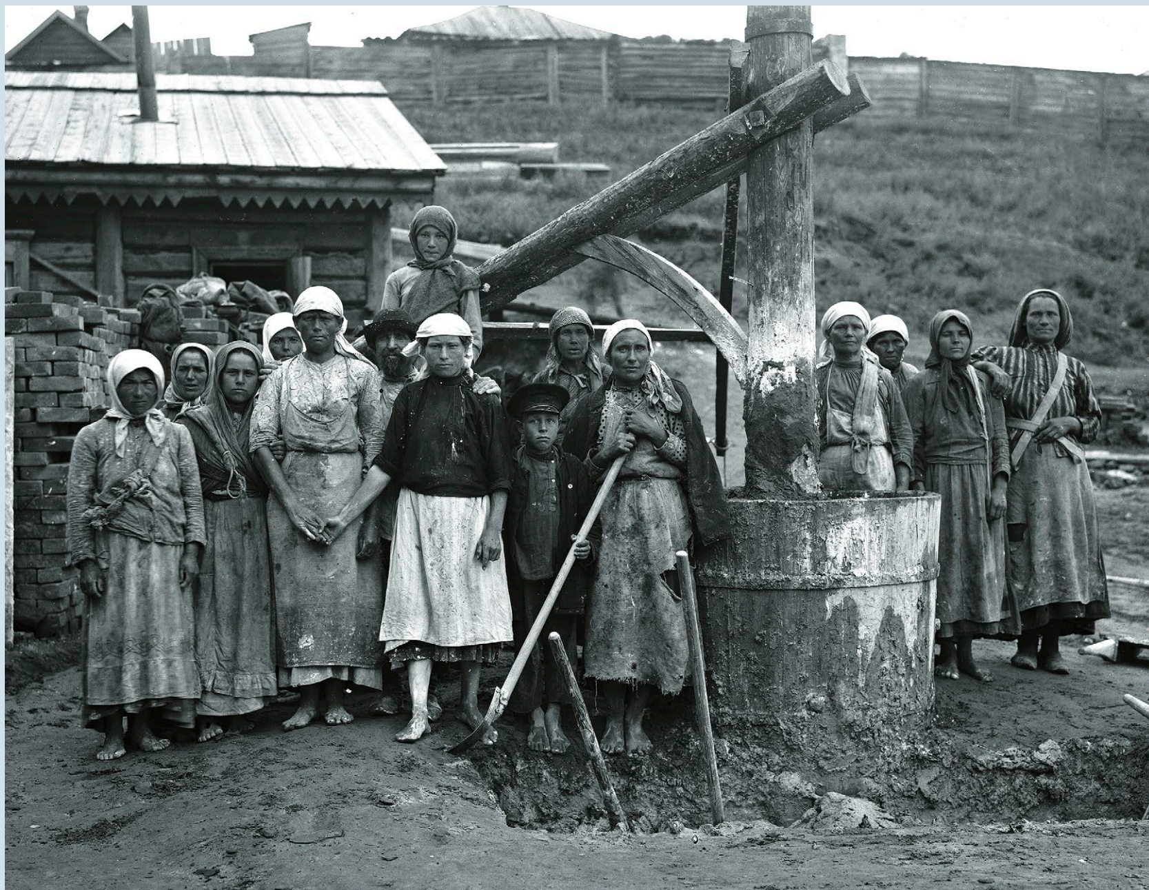
Постройка здания музея, группа работниц у мяла для замачивания и размешивания глины, 1914 год
