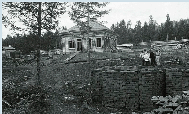
Строительные работы в поселке стекольного завода, 1927–1928 годы Негатив Л. А. Чернышева КККМ
