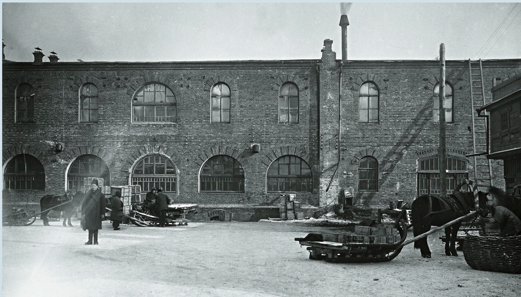
Боковой фасад здания механического цеха фабрики «Спартак», 1930-е годы КККМ
