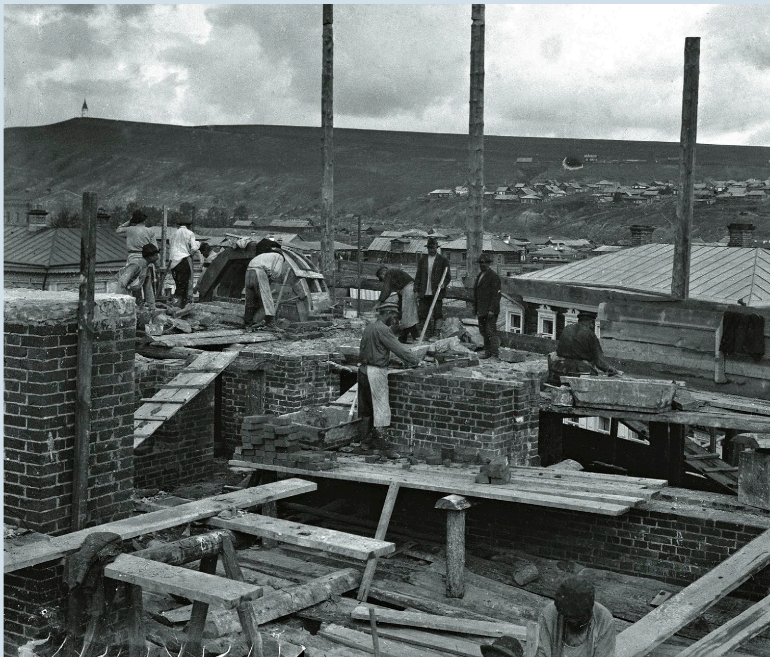
Строительство дома Л. А. Чернышева, 1912–1913 годы Фрагмент стереонегатива Л. А. Чернышева КККМ
