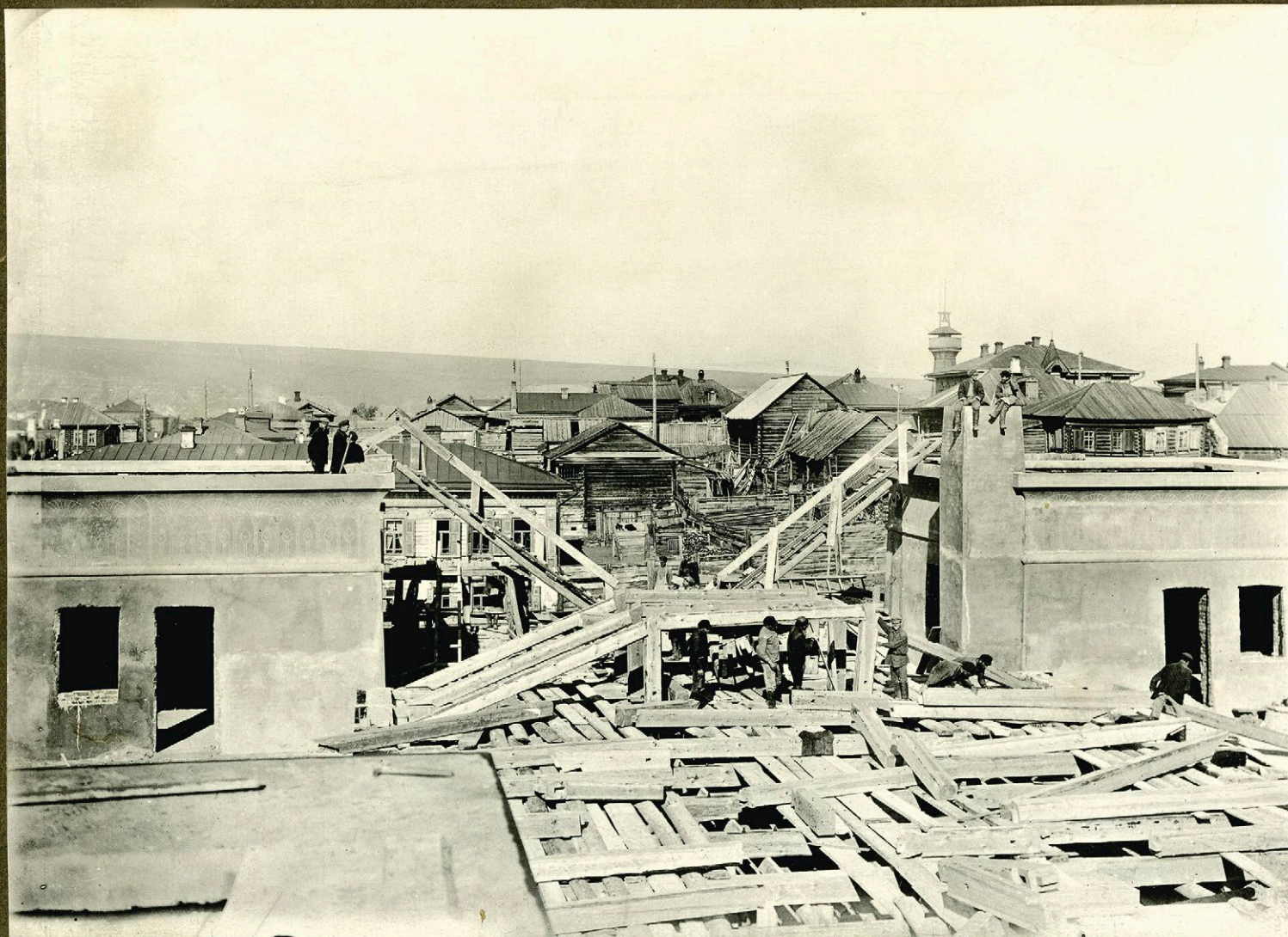
Г. КРАСНОЯРСК. ПОСТРОЙКА НОВОГО МУЗЕЯ. УСТАНОВКА ВРЕМЕННЫХ СТРОПИЛ НА СРЕДНЕЙ ЧАСТИ ЗДАНИЯ. IX-1928 г.
