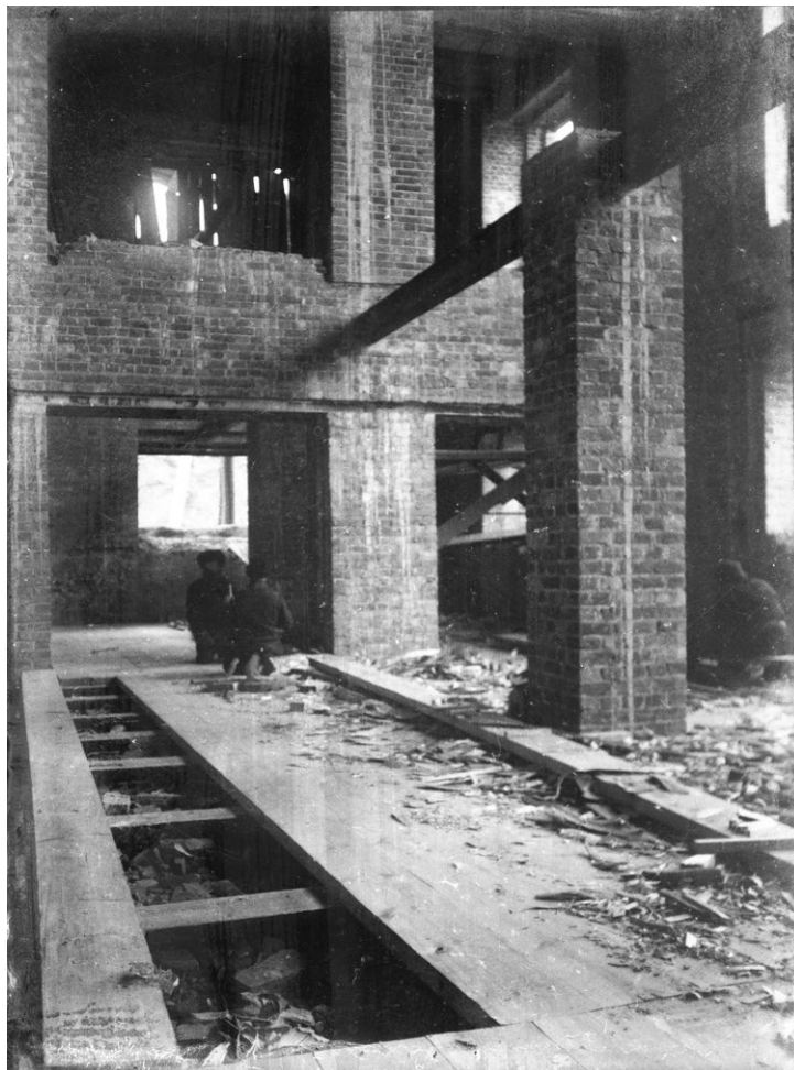
Укладка деревянных полов в недостроенном здании музея. Осень 1915 г. Пленочный негатив. Л. А. Чернышев. КККМ.
