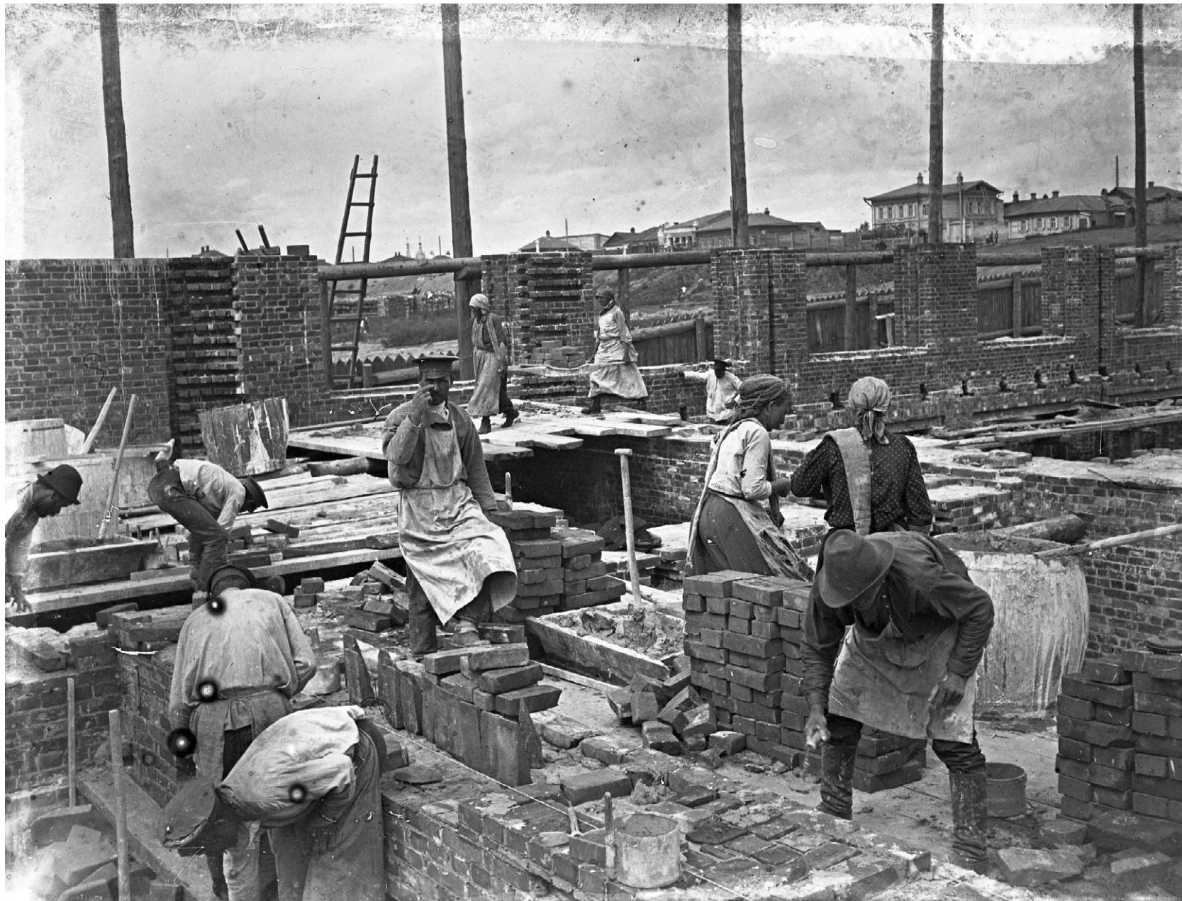
Группа строителей, занимающихся кирпичной кладкой. 1914 г. Пленочный негатив. Л. А. Чернышев. КККМ.
