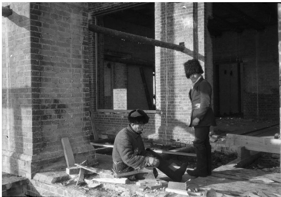
Укладка деревянных полов в недостроенном здании музея. Осень 1915 г. Пленочный негатив. Л. А. Чернышев. КККМ.
