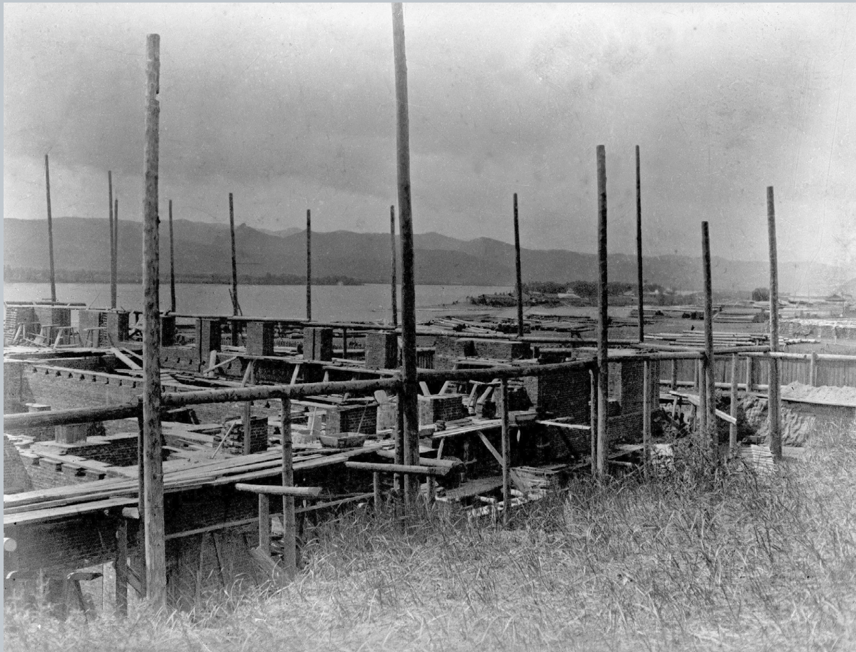
Общий вид на стройку здания городского музея. 1914 г. Пленочный негатив. Л. А. Чернышев. КККМ.
