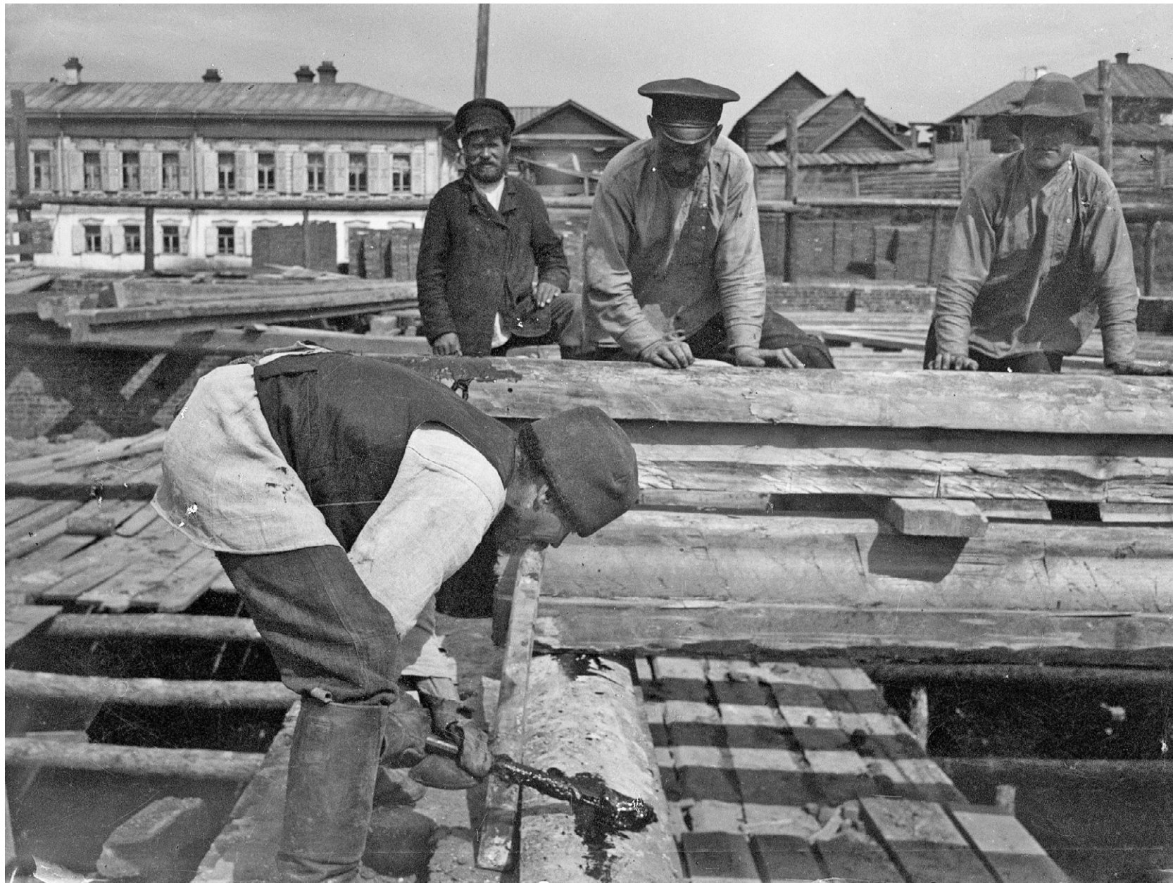
Обработка балок перекрытий битумом. 1914 г. Пленочный негатив. Л. А. Чернышев. КККМ.
