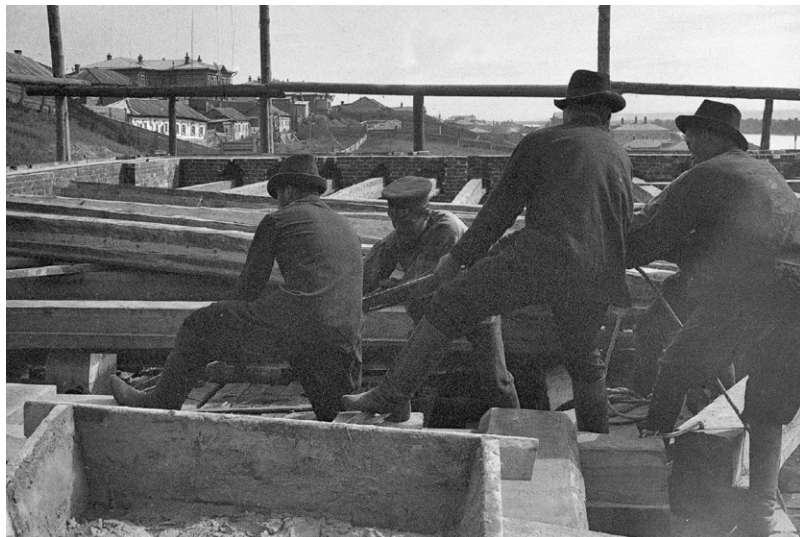
Укладка балок перекрытий. 1914 г. Пленочный негатив. Л. А. Чернышев. КККМ.
