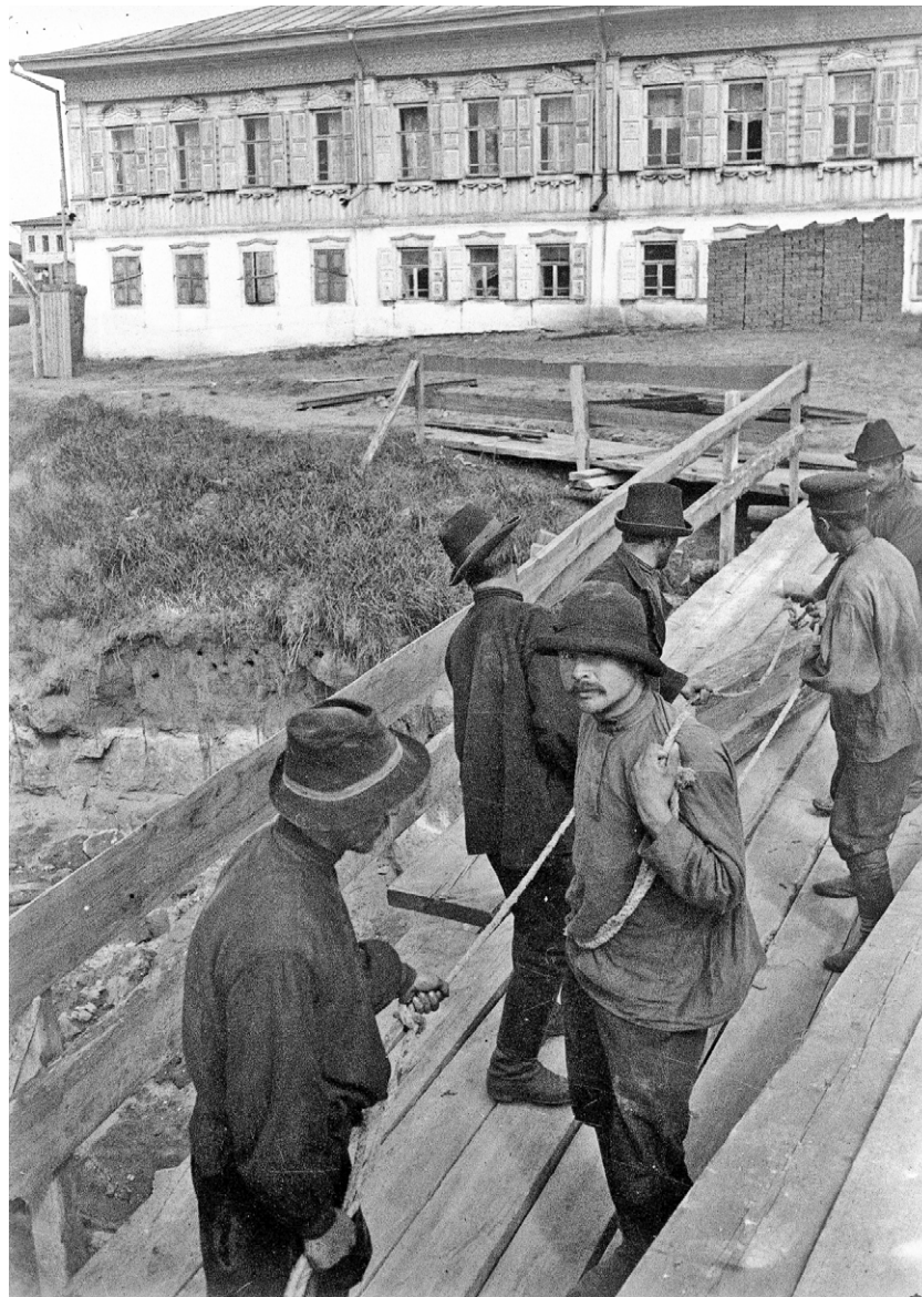
Перетаскивание балок перекрытий. 1914 г. Пленочный негатив. Л. А. Чернышев. КККМ.
