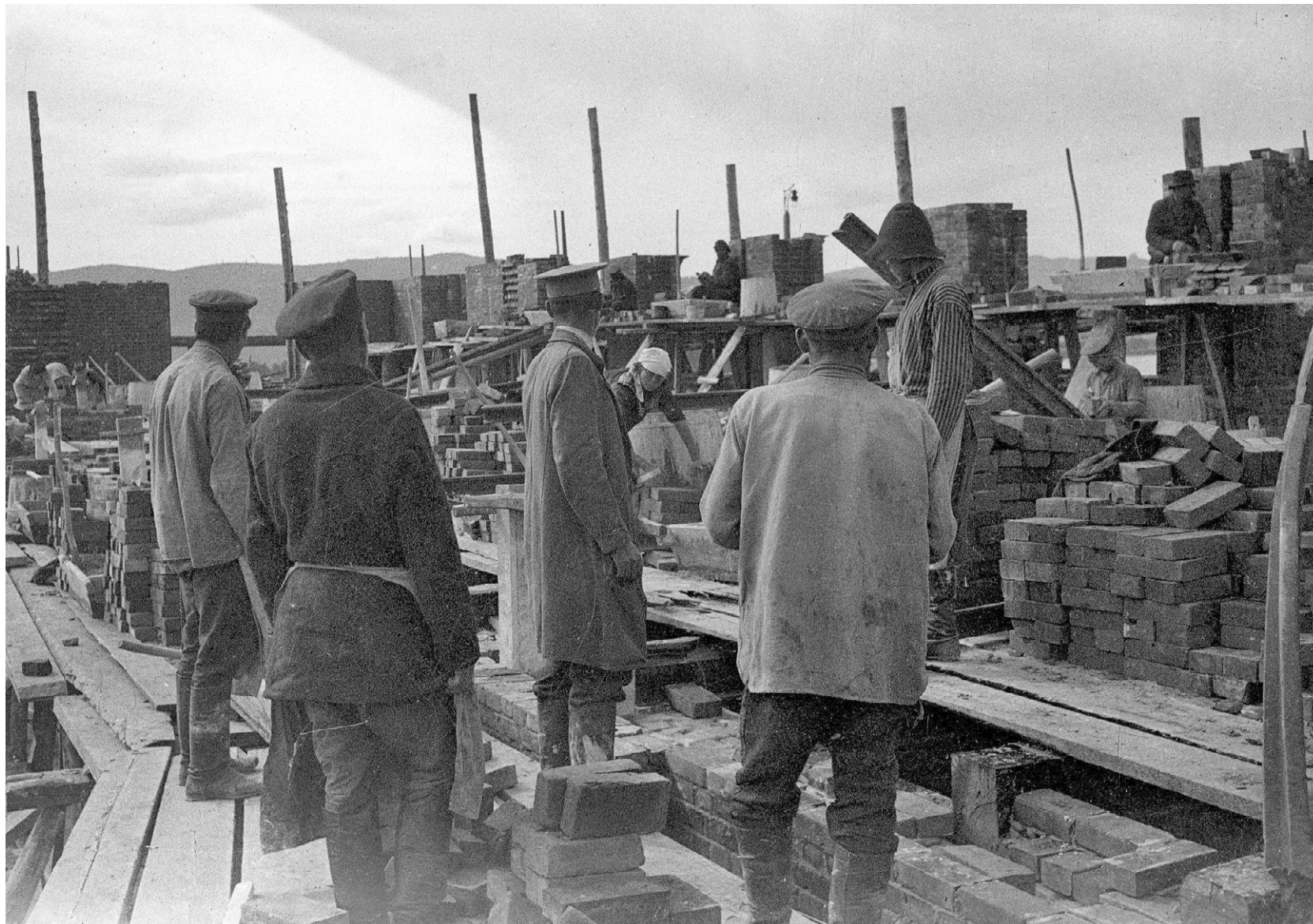
Группа строителей, занимающихся кирпичной кладкой. 1914 г. Пленочный негатив. Л. А. Чернышев. КККМ.
