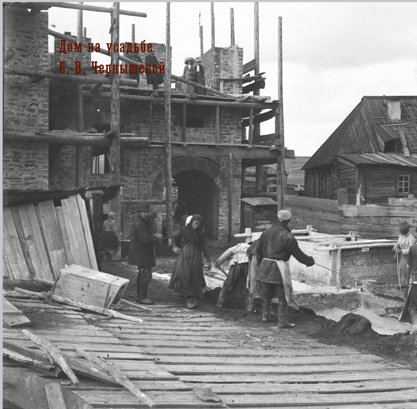
Строительство дома на усадьбе Е. В. Чернышевой. [1912 г.]. Часть стеклянного стереонегатива. Л. А. Чернышев. КККМ.
