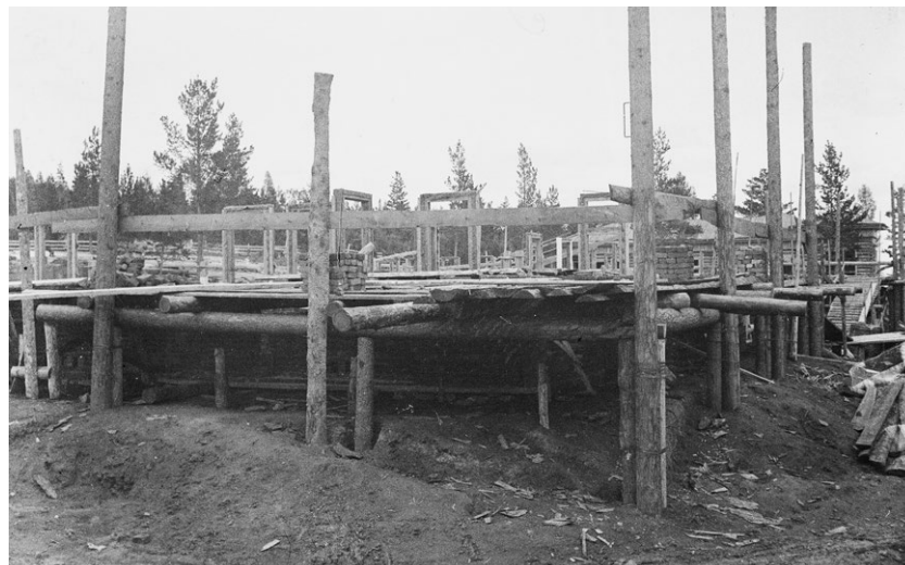
Постройка фундамента для здания больницы в пос. Стеклозавод. [1927–1928 гг.]. Стекланный негатив. Л. А. Чернышев. КККМ.
