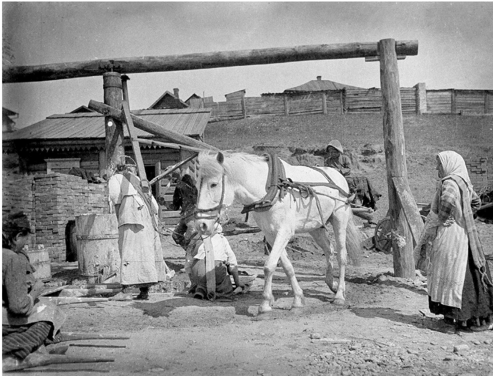
Замешивание строительного раствора при помощи лошади. 1914 г. Пленочный негатив. Л. А. Чернышев. КККМ.
