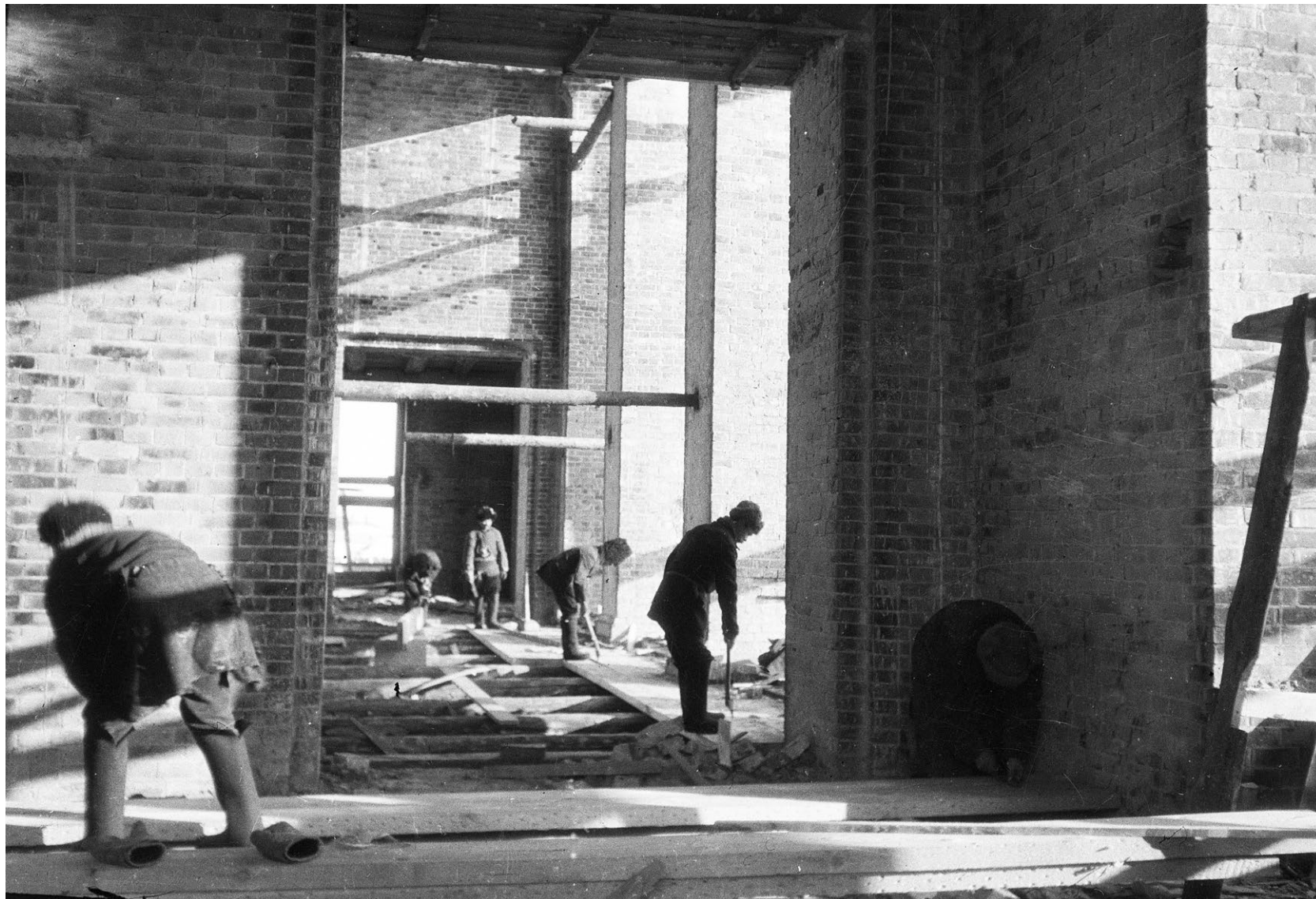
Укладка деревянных полов в недостроенном здании музея. Осень 1915 г. Пленочный негатив. Л. А. Чернышев. КККМ.
