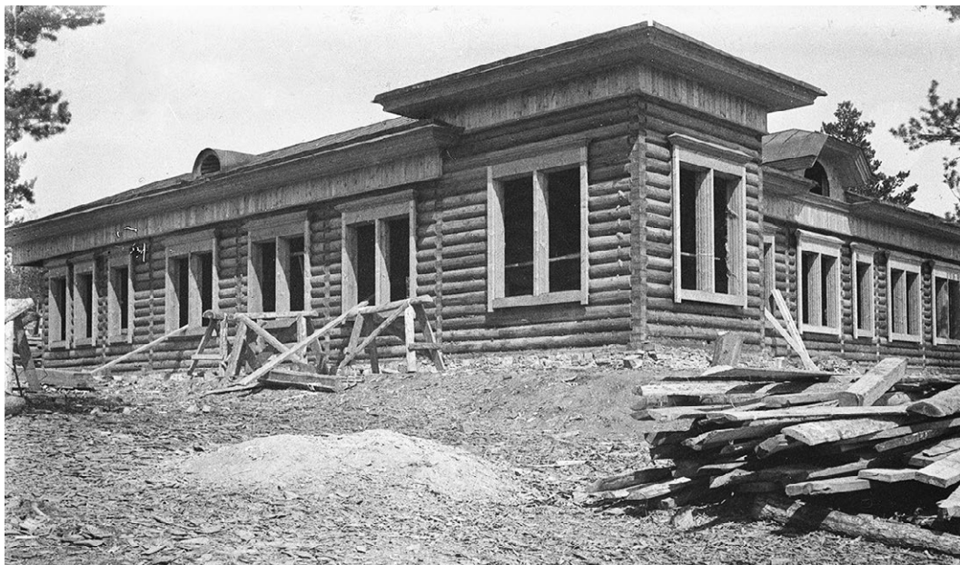
Постройка одноэтажного деревянного здания в пос. Стеклозавод. [1927–1928 гг.] Стеклянный негатив. Л. А. Чернышев. КККМ.
