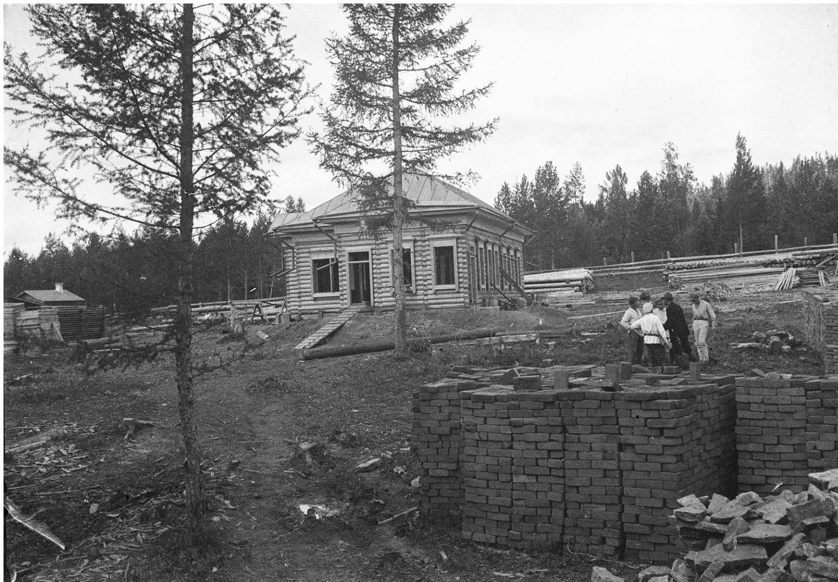
Постройка одноэтажного деревянного дома для комплекса больницы в пос. Стеклозавод. [1927–1928 гг.]. Стекланный негатив. Л. А. Чернышев. КККМ.
