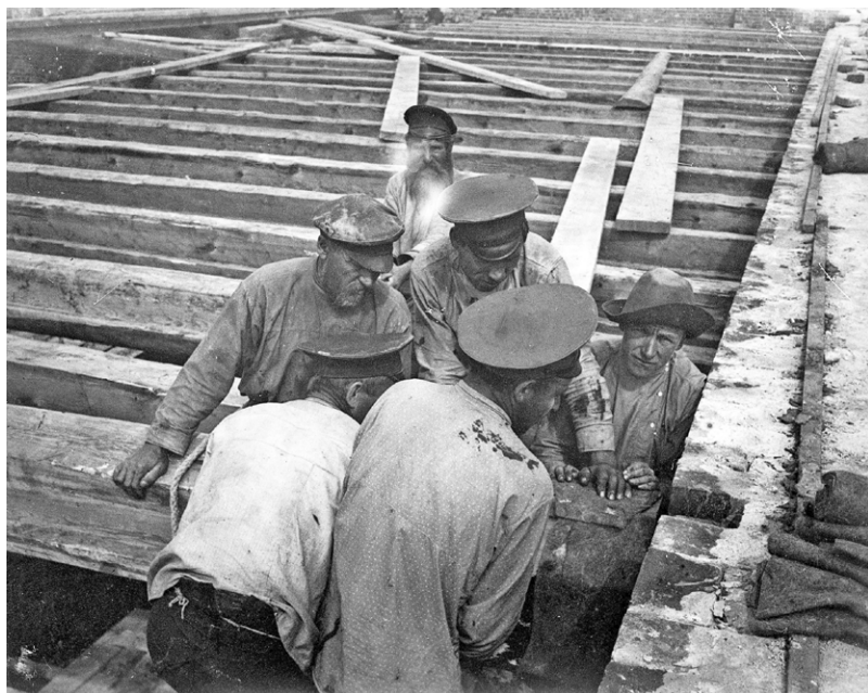
Укладка балок перекрытий. 1914 г. Пленочный негатив. Л. А. Чернышев. КККМ.
