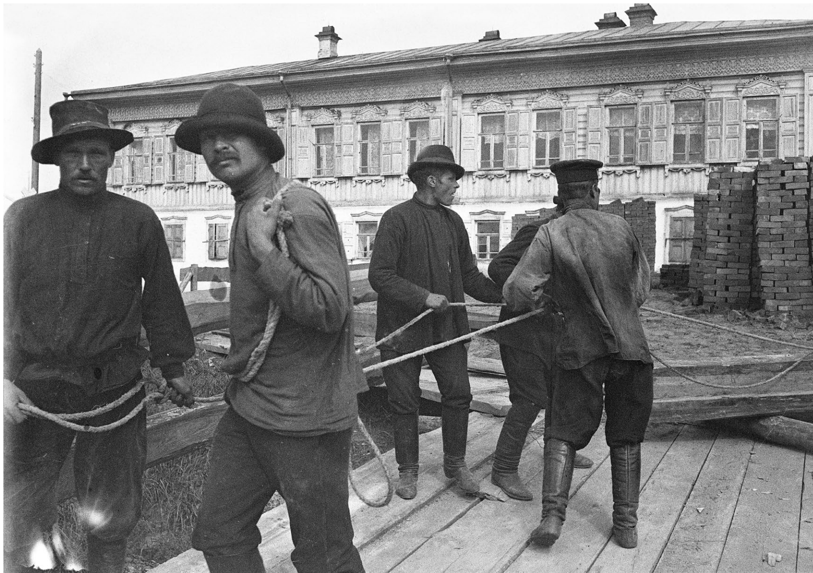
Установка балок перекрытий. 1914 г. Пленочный негатив. Л. А. Чернышев. КККМ.
