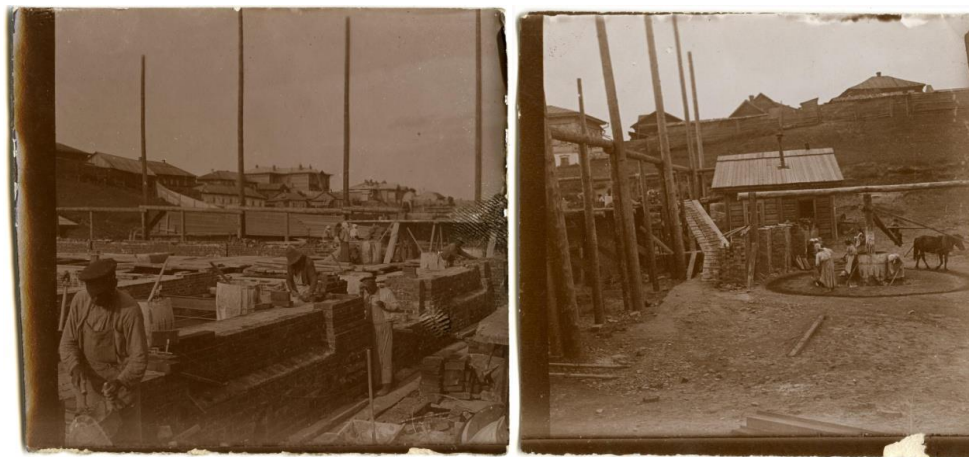
Строительство здания музея
