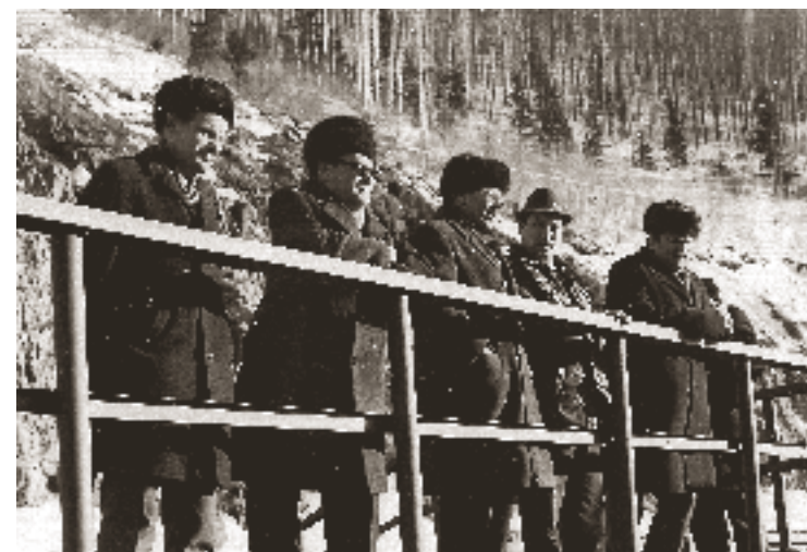
На строительстве Саяно-Шушенской ГЭС
