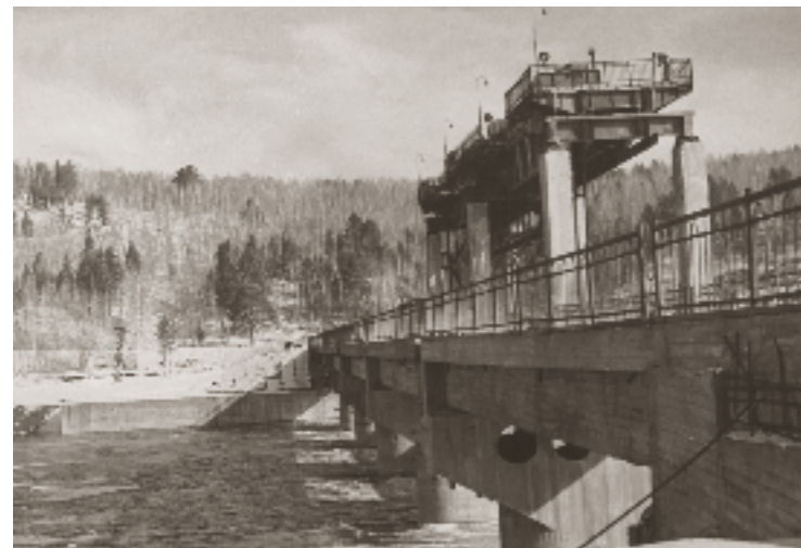
Плотина Назаровской ГРЭС, 1962 год
