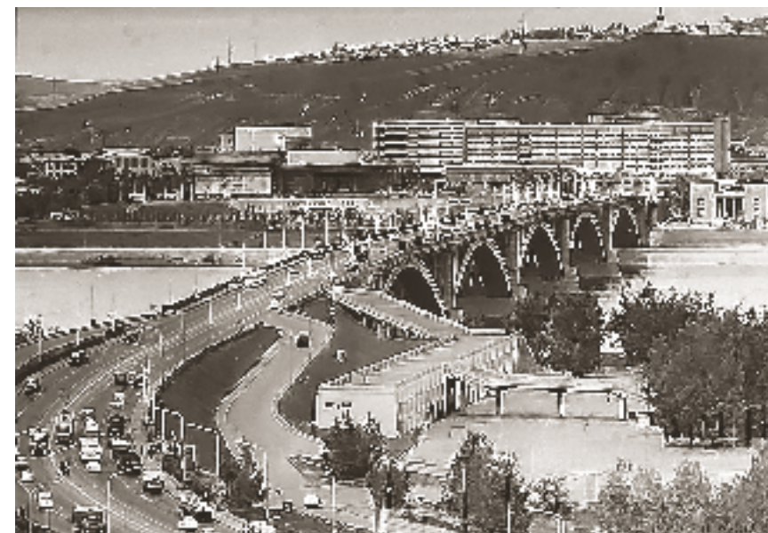
Красноярск, Коммунальный мост
