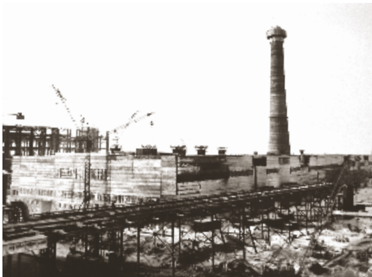
Строительство Надеждинского металлургического завода
