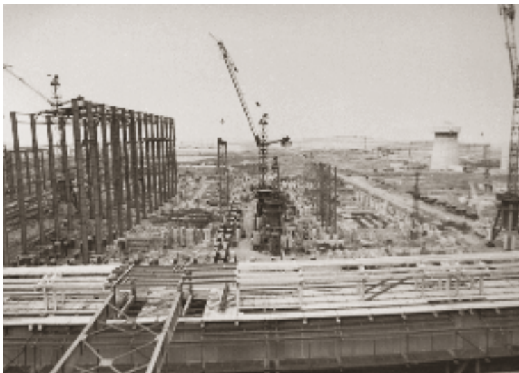
Строительство Надеждинского металлургического завода идет полным ходом
