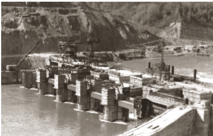
Строительство Красноярской ГЭС, 1964 год
