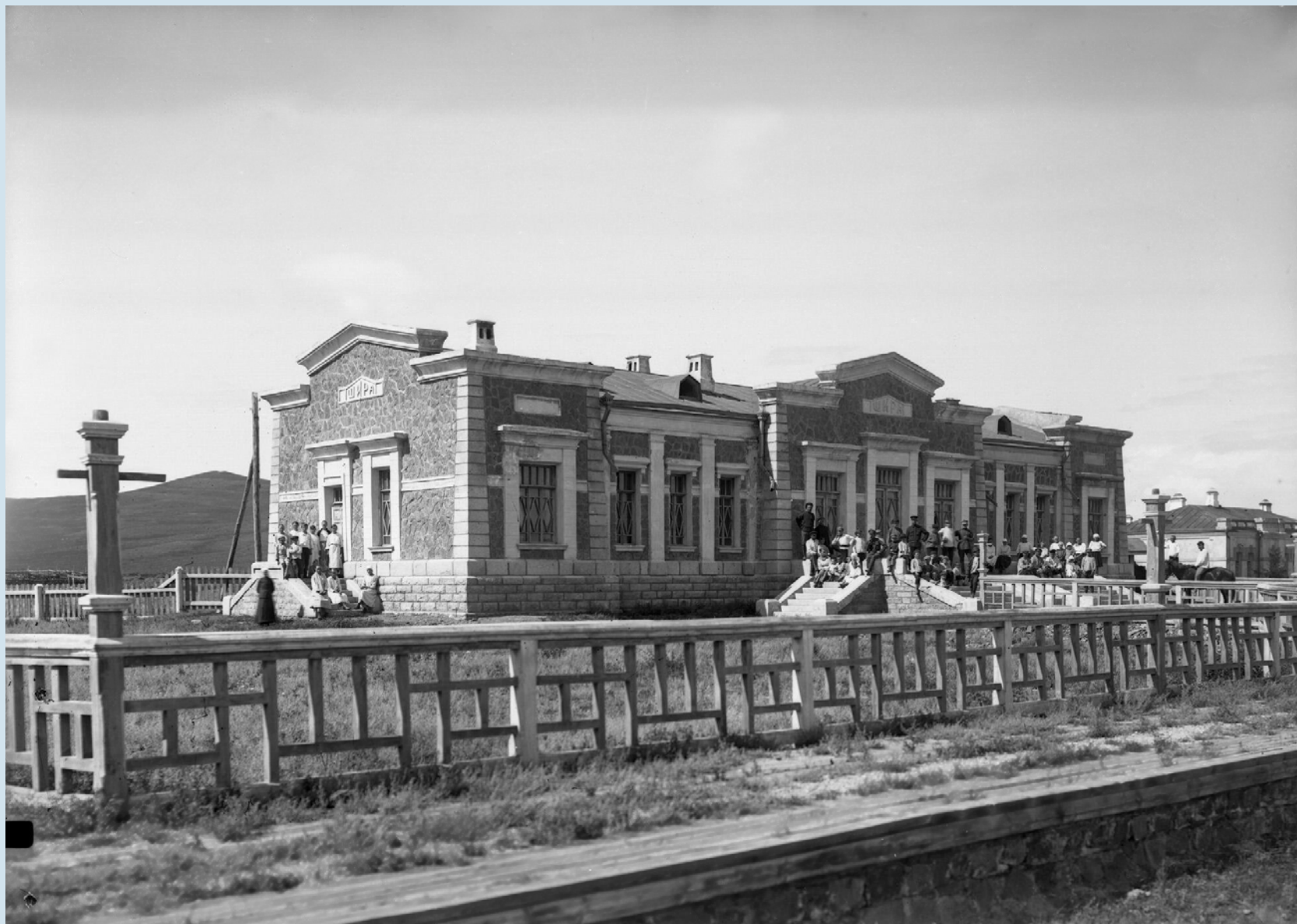
Станция Ши́ра Ачинско-Минусинской железной дороги. 1920-е гг.
